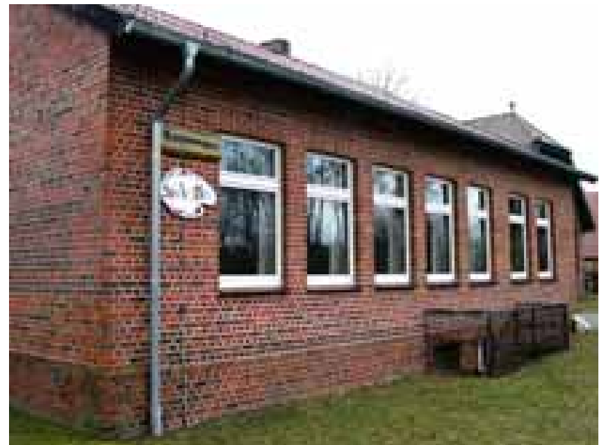
Wilhelm Brüggemann und Peter Petzold wollen einen »Förderverein Güster e. V.« gründen, um trotz der leeren Gemeindegasse das schöne alte Gebäude zu erhalten. Foto: Peter Heinrich
